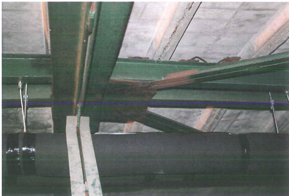
Mocowanie stężenia połaciowego do blachy węłowej. Korozja.
