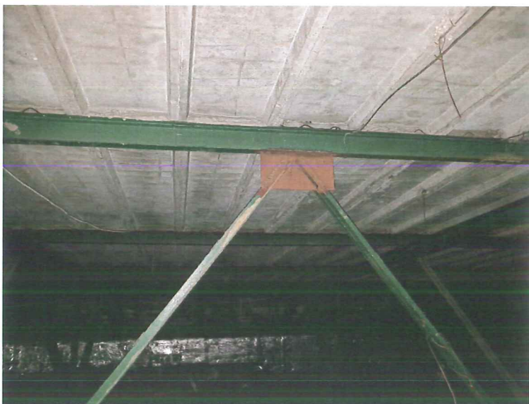
Widok układu płyt korytkowych – stan istniejący
