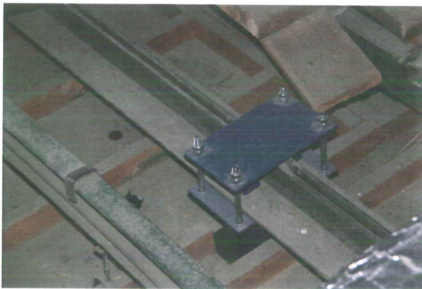
Mocowanie kosza do pasa dolnego dźwigara.
