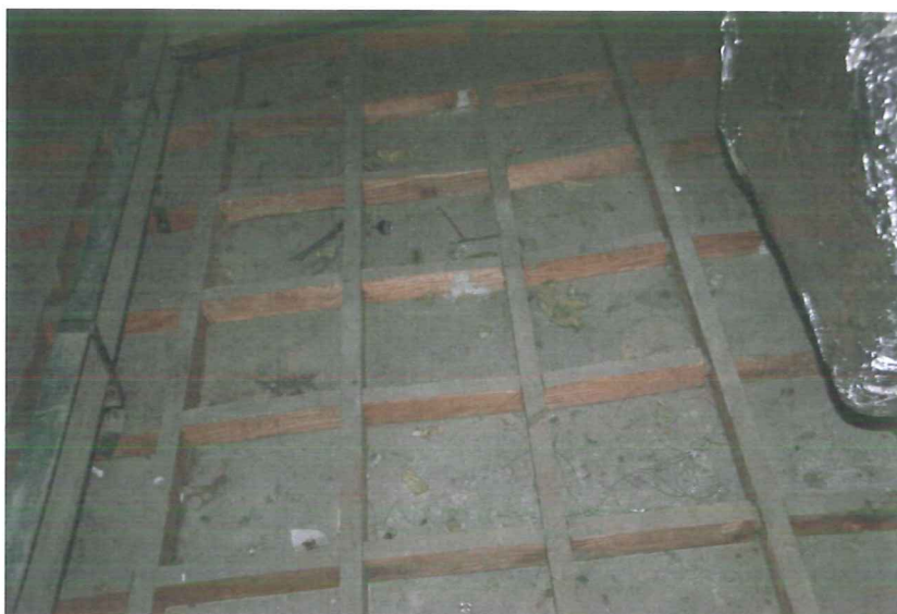
Ruszt drewniany sufitu podwieszonego. Widoczne odkształcenia.
