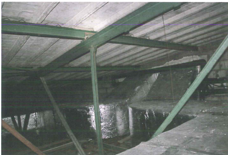
Oparcie płatwi w węźle dźwigara. Widoczne ugięcia płatwi.
