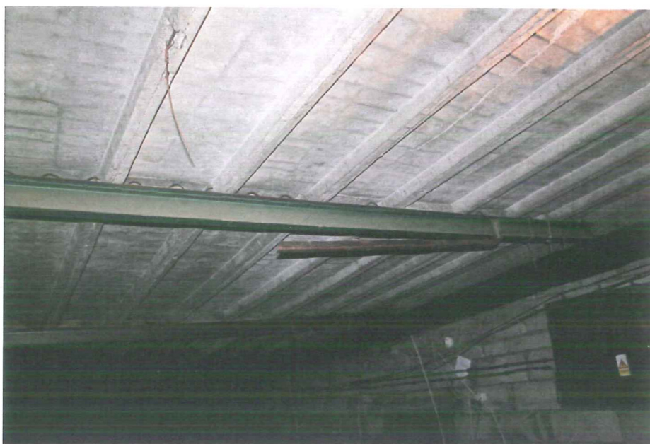
Płatew pośrednia z nakładką na pasie górnym z blachy.
