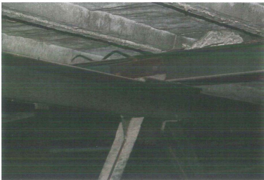
Węzeł płatew – krzyżulce – pas górny. Braki w monolityzacji płyty żelbetowej i płatwi.
