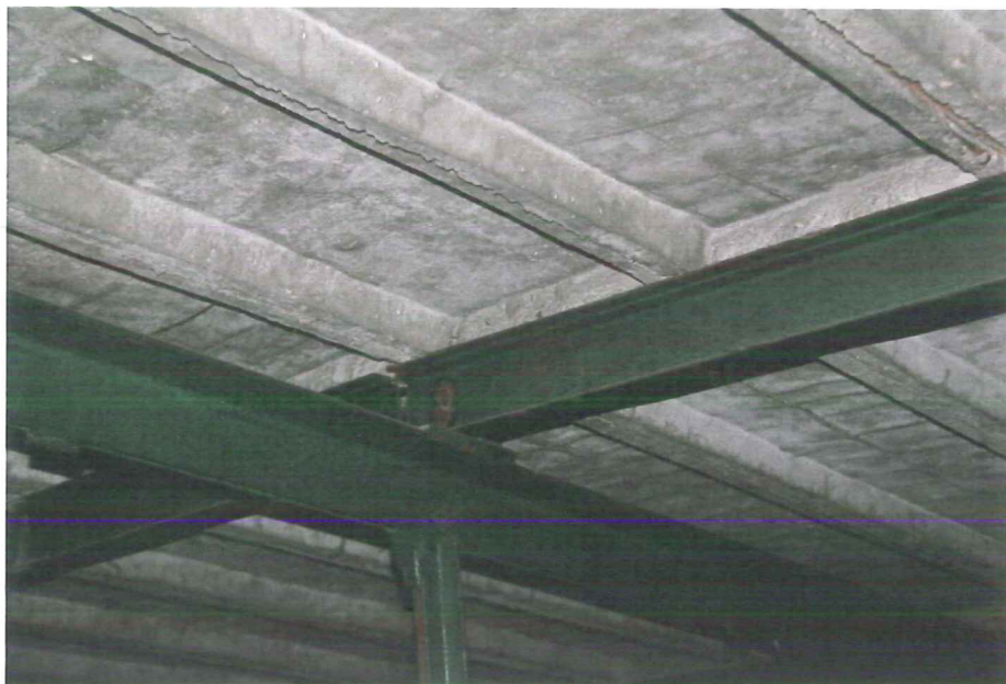
Przegubowe połączenie płatwi. Widoczne płyty korytkowe.
