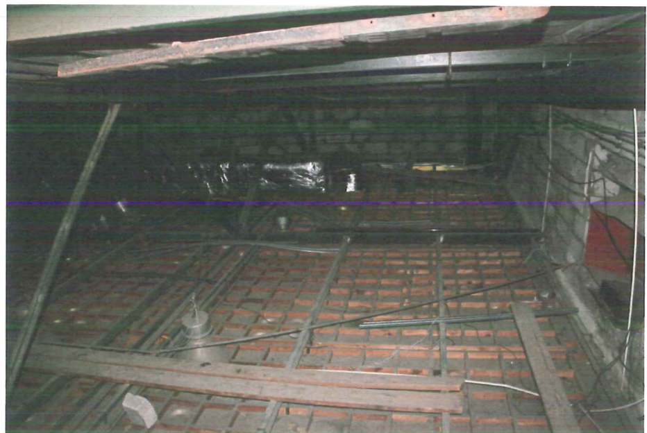
Sufit podwieszony. Widoczne mocowanie lampy oświetlającej halę oraz deski służące, jako pomosty. Ściany zamykające przestrzeń poddasza murowane.
