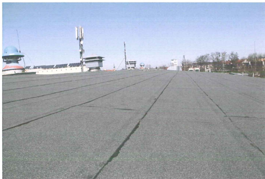
Nierówności połaci dachowej wynikające z trwałych ugięć płatwi.
