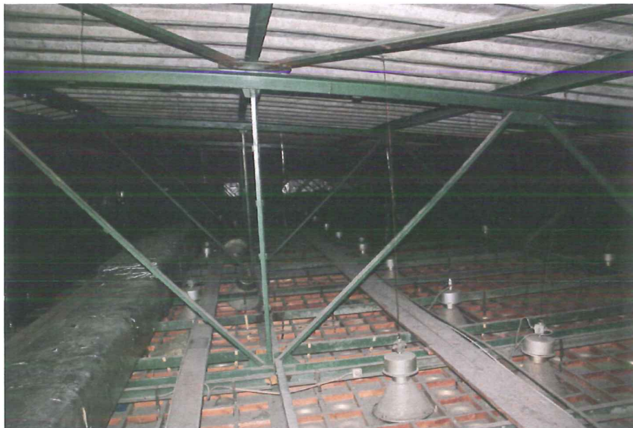
Odkształcone krzyżulce oraz słupki.
