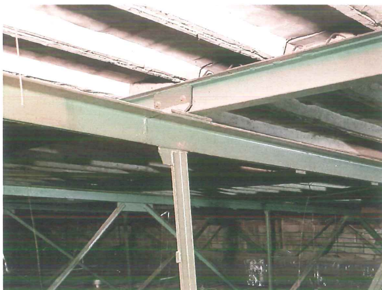
Widok węzła podporowego płatwii
