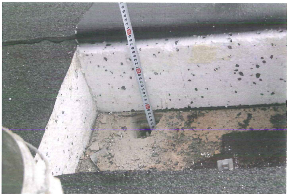
Odkrywką. Widoczne nowe i stare pokrycie.
