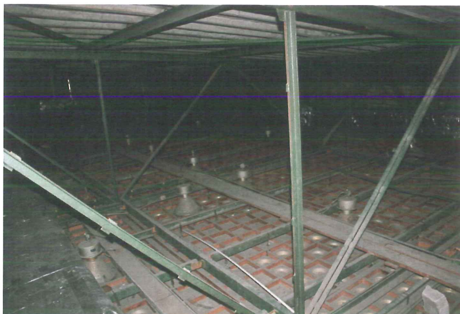
Konstrukcja sufitu podwieszonego. Widoczne usytuowane w sposób ortogonalny belki stalowe i podwieszony na stalowych wieszakach ruszt drewniany. W tle wybozczone krzyżulce i słupki dźwigarów.
